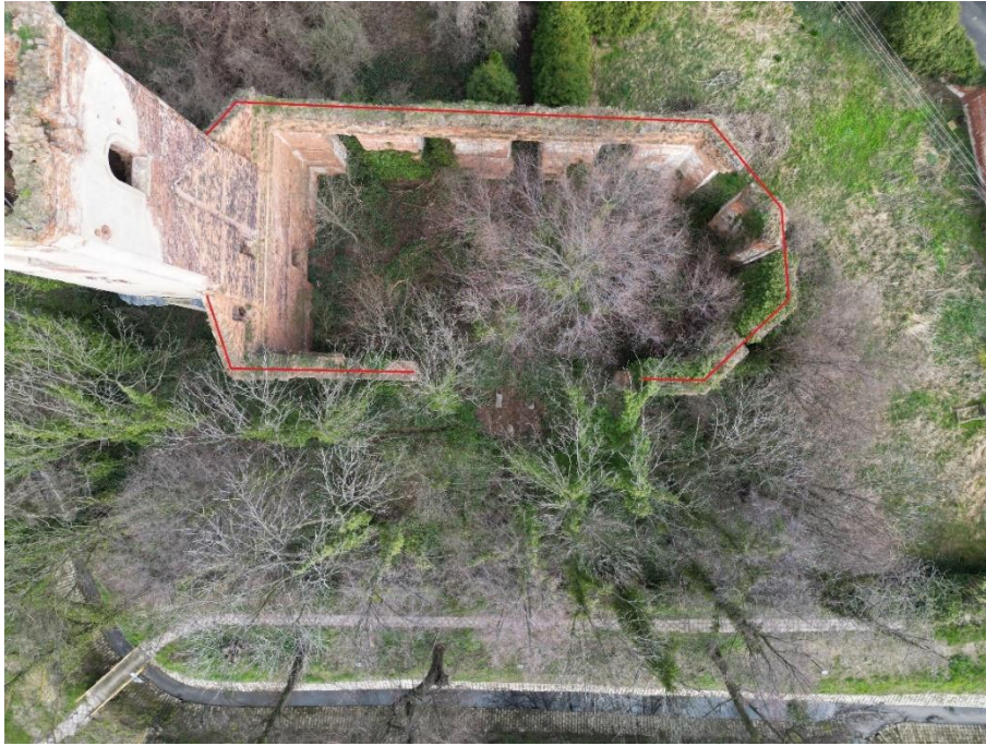
Zdj. 20. Miejsca zabezpieczenia korony murów ścian obróbką blacharską.
