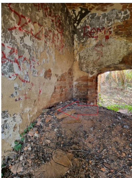
Zdj. 4. Obszar schodów lub schowka, z których należy usunąć gruz, kamienie oraz ziemię.
