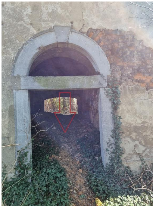
Zdj. 2. Obszar przedsionka, z którego należy usunąć gruz, kamienie oraz ziemię.
