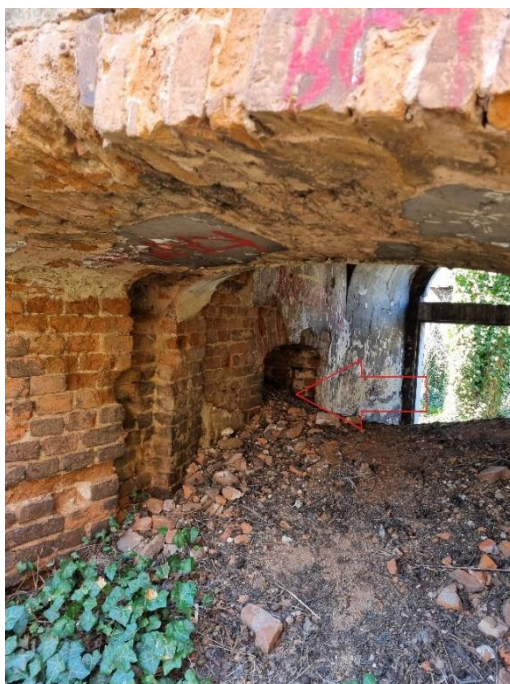
Zdj. 3. Obszar schodów lub schowka, z których należy usunąć gruz, kamienie oraz ziemię.
