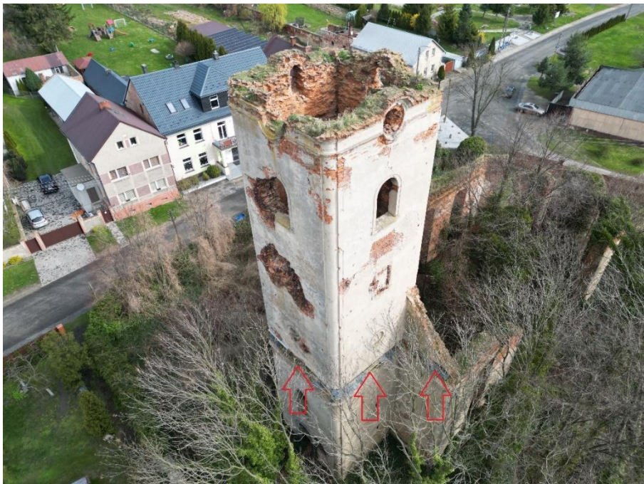
Zdj. 10. Gzyms, z którego należy usunąć roślinność i dachówki.
