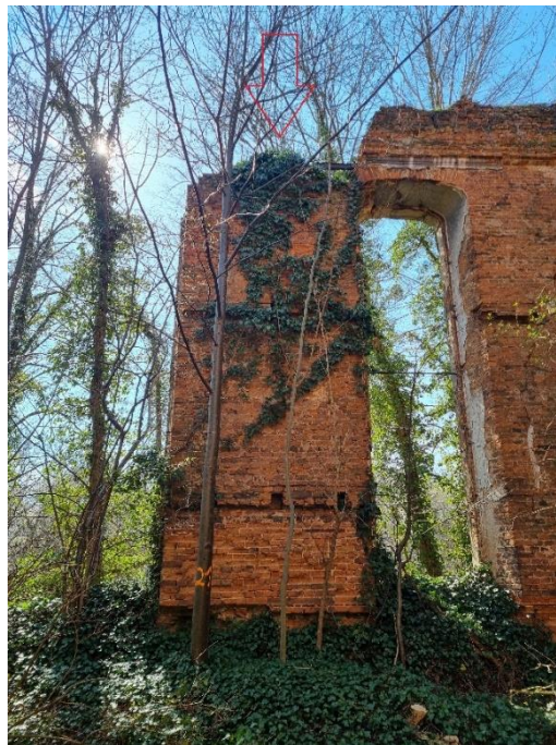
Zdj. 16. Otwór okienny, nad którym należy odtworzyć fragment ściany.
