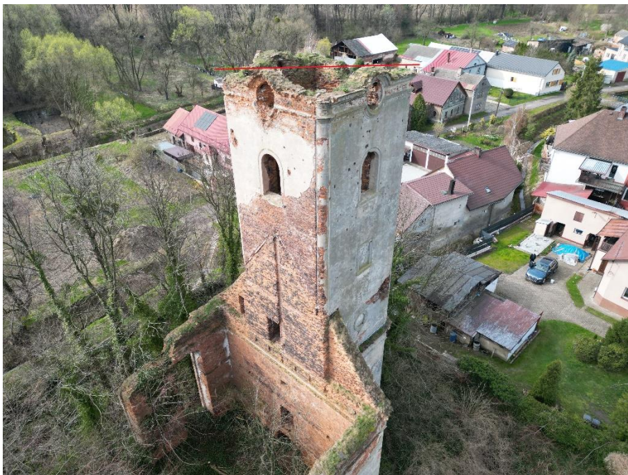
Zdj. 8. Linia okien, do których należy wyrównać koronę muru wieży.
