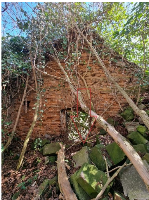
Zdj. 5. Obszar zakrystii, z której należy usunąć gruz, kamienie oraz ziemię.
