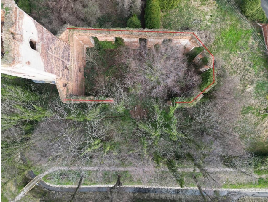
Zdj. 19. Miejsca wykonania wieńca żelbetowego.
