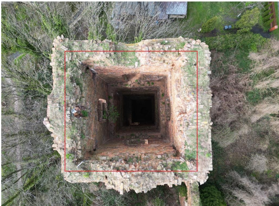
Zdj. 21. Miejsca zabezpieczenia korony muru wieży obróbką blacharską.
