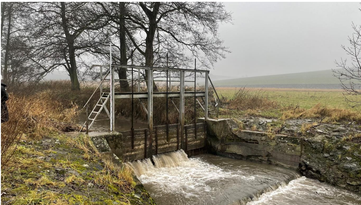
Fot. 1 Jaz w km 13+300 rzeki Troja przeznaczony do rozbiórki.
