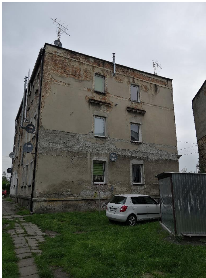
Rys. nr 5. Widok budynku przy ul. Długiej 25 w Kietrz – elewacja wschodnia
