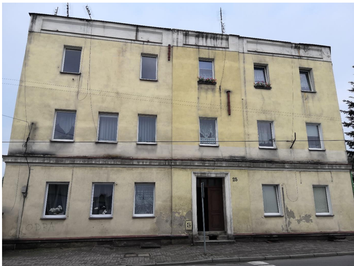
Rys. nr 2. Widok budynku przy ul. Długiej 25 w Kietrze – elewacja południowa
