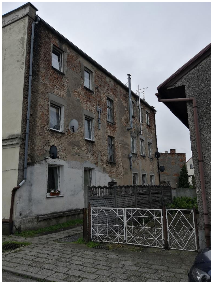
Rys. nr 3. Widok budynku przy ul. Długiej 25 w Kietrz – elewacja północna
